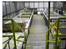
Foto 02. Vista dos fundos da ETE
