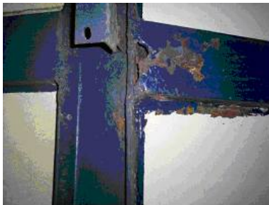
Foto 10. Vista de patologias em áreas de solda na ETE.
