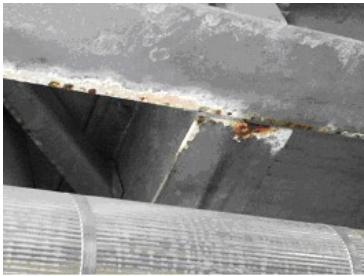
Foto 36. Patologias de oxidação vermelha em junções.
