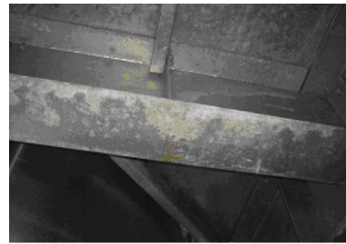
Foto 34. Patologias na estrutura, oxidação branca. Foto 35. Patologias com severa oxidação branca.
