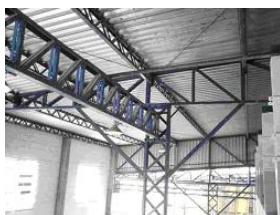
Foto 03. Vista da cobertura da moagem.
