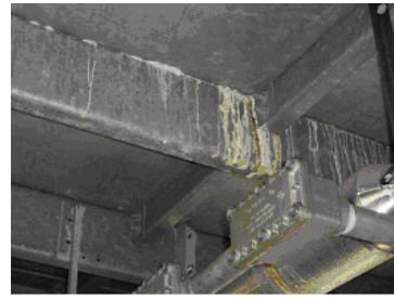
Foto 37. Patologias de severa oxidação branca em frestas com derrame de produtos.
