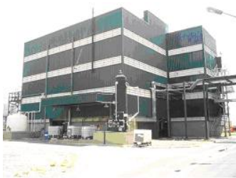
Foto 07. Vista da fachada esquerda da Indústria II.
