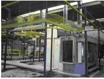
Foto 05. Vista da estrutura da esmaltação.
