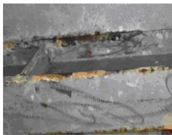
Foto 37. Patologias de severa oxidação branca em frestas com derrame de produtos.
