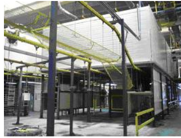
Foto 06. Vista da estrutura da esmaltação.
