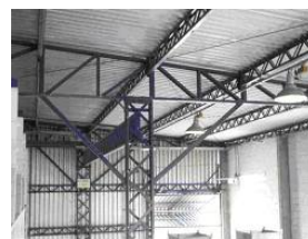
Foto 04. Vista do cobertura da moagem.
