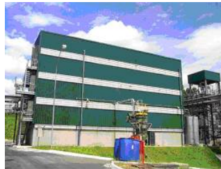
Foto 08. Vista fachada direita da Indústria II.
