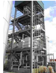
Foto 09. Vista da estrutura metálica da Indústria II.
