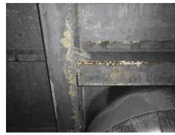
Foto 37. Patologias de severa oxidação branca em frestas com derrame de produtos.
